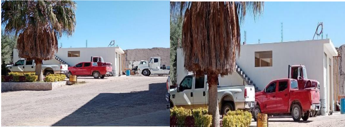
Figura 9. 1 Nuevo almacén Fuente: SACROSA
