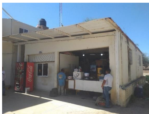
Figura 4. 2 Parte frontal almacén Fuente: SACROSA
